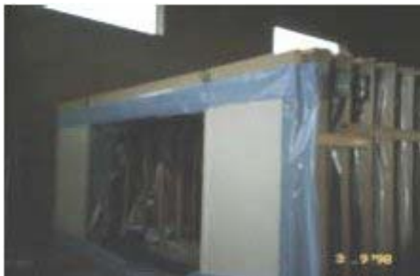
Fig. 1.17. Folie pentru minimizarea infiltrațiilor aerului prin pereți www.passivhaustagung.de
